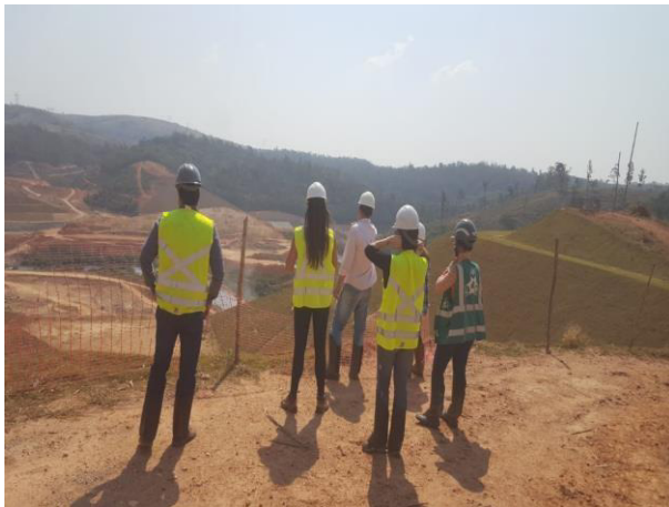
Foto 15: Visita CETESB – Ombreira Direita - BP. 05/10/2020.
