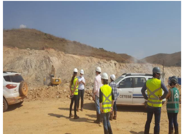
Foto 14: Visita CETESB – Ombreira Direita - BP. 05/10/2020.
